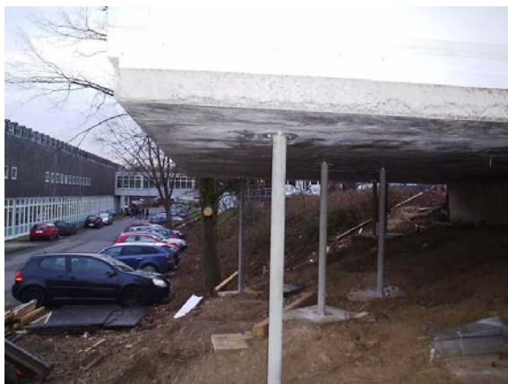
Bild 1 Stützen aus Hochleistungsbeton bei einem Experimentalbau
