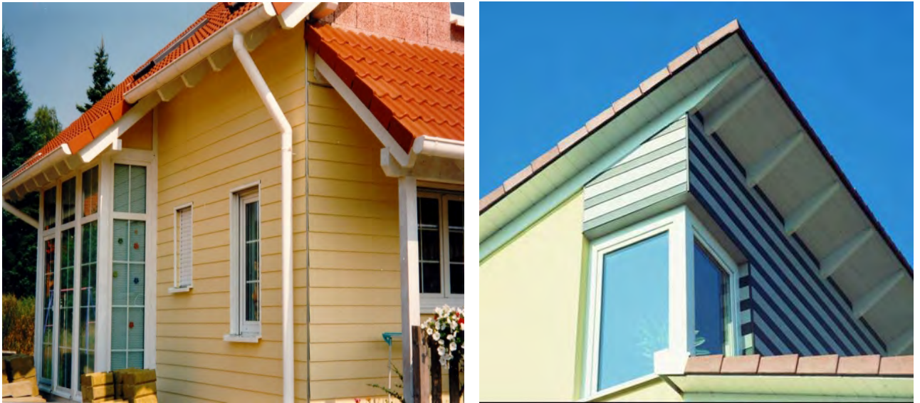
Abb. 1: Balkonverkleidungen und Fassadenelemente aus Holzwerkstoffen
